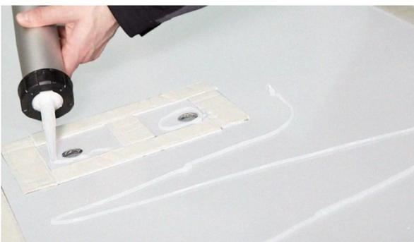
**3.7 a** Tragen Sie im Anschluss das essigsäurefrei vernetzende Natursteinsilikon (erhältlich in unserem Montage Kit) wellenförmig auf. Ausschnitte und Bohrungen ebenfalls mit diesem Silikon versehen, wie im Bild oben gezeigt.
