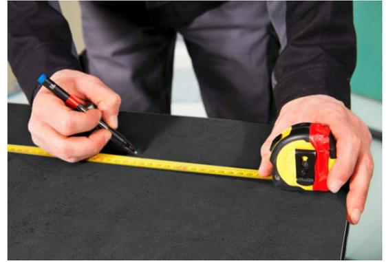
**2.3** Übertragen Sie nun die fertigen Zuschnittmaße mittels wasserlöslichen Folienstift (non-permanent) auf die Frontseite der Designplatte.
