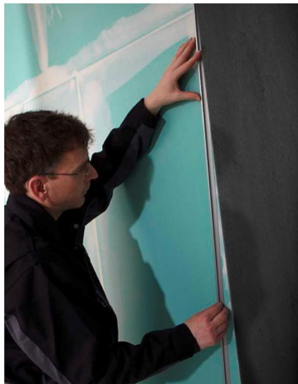
**3.14** Das Abschlussprofil (ebenfalls mit einer dünnen Linie auf der Flanke silikonieren) kann vor oder unmittelbar nach dem Anbringen der Platte aufgesetzt werden.
