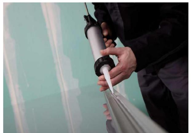
**3.11** Die Profilflanken mit einer durchgehenden dünnen Linie essigsäurefrei vernetzendem Naturstein-Silikon versehen und Profil aufkleben.
