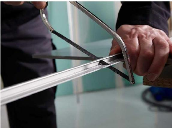
**3.8** Im nächsten Schritt müssen die von Ihnen verwendeten Profile auf Plattenmaß gesägt werden.
