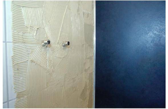
**3.7 b** Nach Abschluss der Arbeiten sollte die Wand flächig mit dem Kleber benetzt sein.
