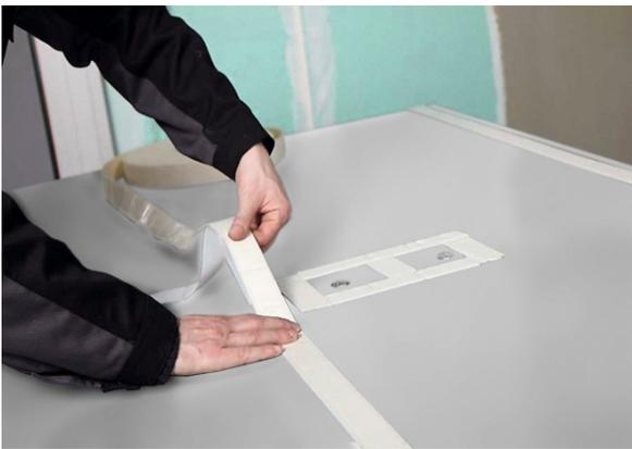
**3.5 a** Entfernen Sie vor dem Aufbringen der Klebmaterialien die Schutzfolie auf der Rückseite der Alu-Designplatte.
