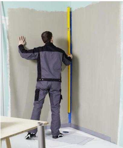
**1.1** Prüfen Sie, ob sich die Wände im Lot befinden. Die Fläche muss tragfähig, trocken, schmutz- und fettfrei sein.
