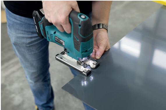
3. Zuschneiden der Duschrückwände sowie Bohrungen und Ausschnitte einbringen
