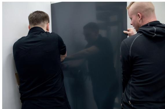
7. Rückwände positionieren, anbringen und abdichten.
