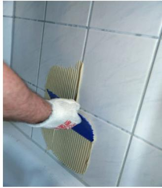
**3.6 b** Tragen Sie den fertig angerührten Flächenkleber auf die zu beklebende Wand auf.
